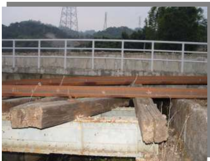
圖 4-8 可以看出原本高度相同的鐵軌已產生高 低落差。
