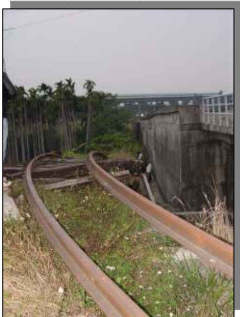
圖 4-6 被抬昇的上盤 鐵軌被抬昇後，造成鐵軌扭曲變形， 枕木脫離
