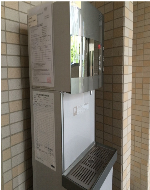
說明：每層樓均有設有飲水機，共4台。有溫水及熱水設備，熱水有鎖定裝置，以防止學童燙傷。
