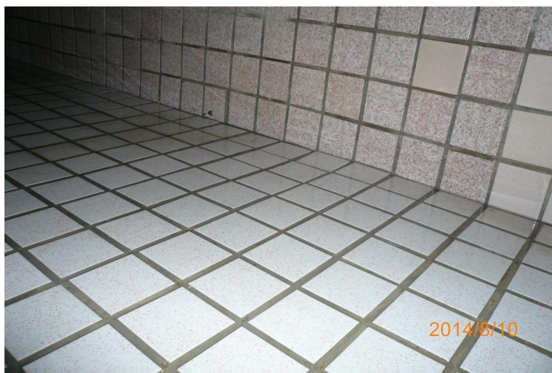
蓄水池清潔照片-清洗後
