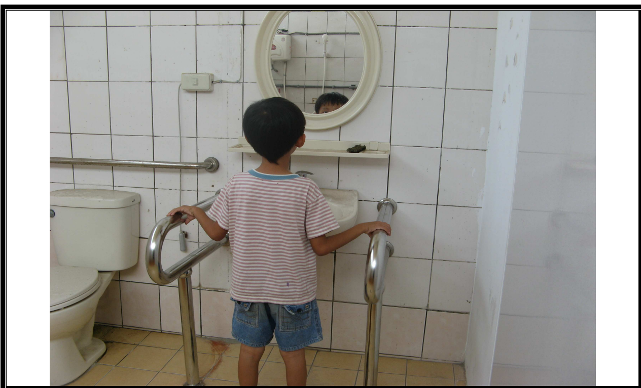
說明：廁所扶手施工完成照片
