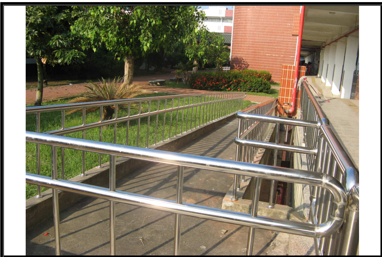
說明：坡道施工完成照片
