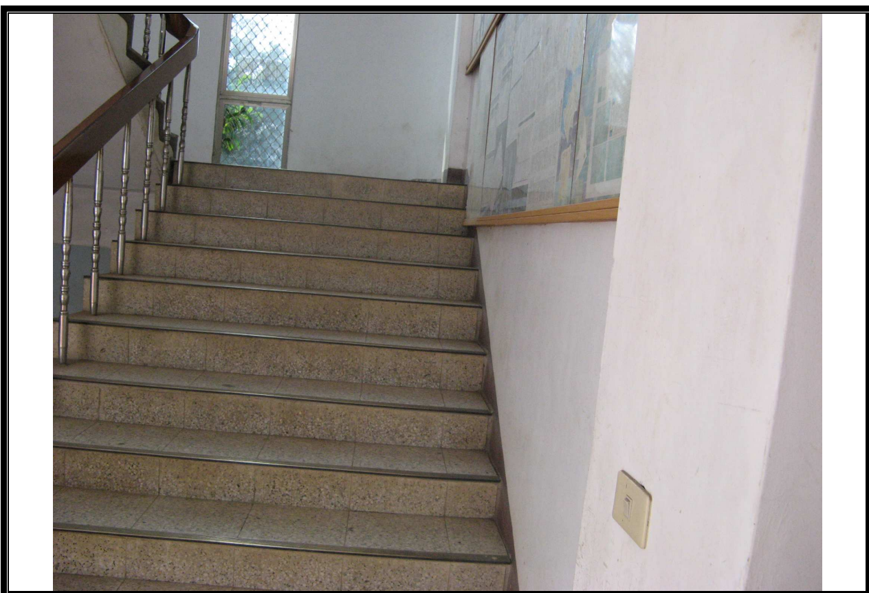
說明：樓梯施工前照片
