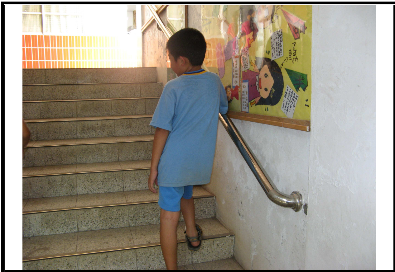
說明：樓梯不銹鋼扶手完工
