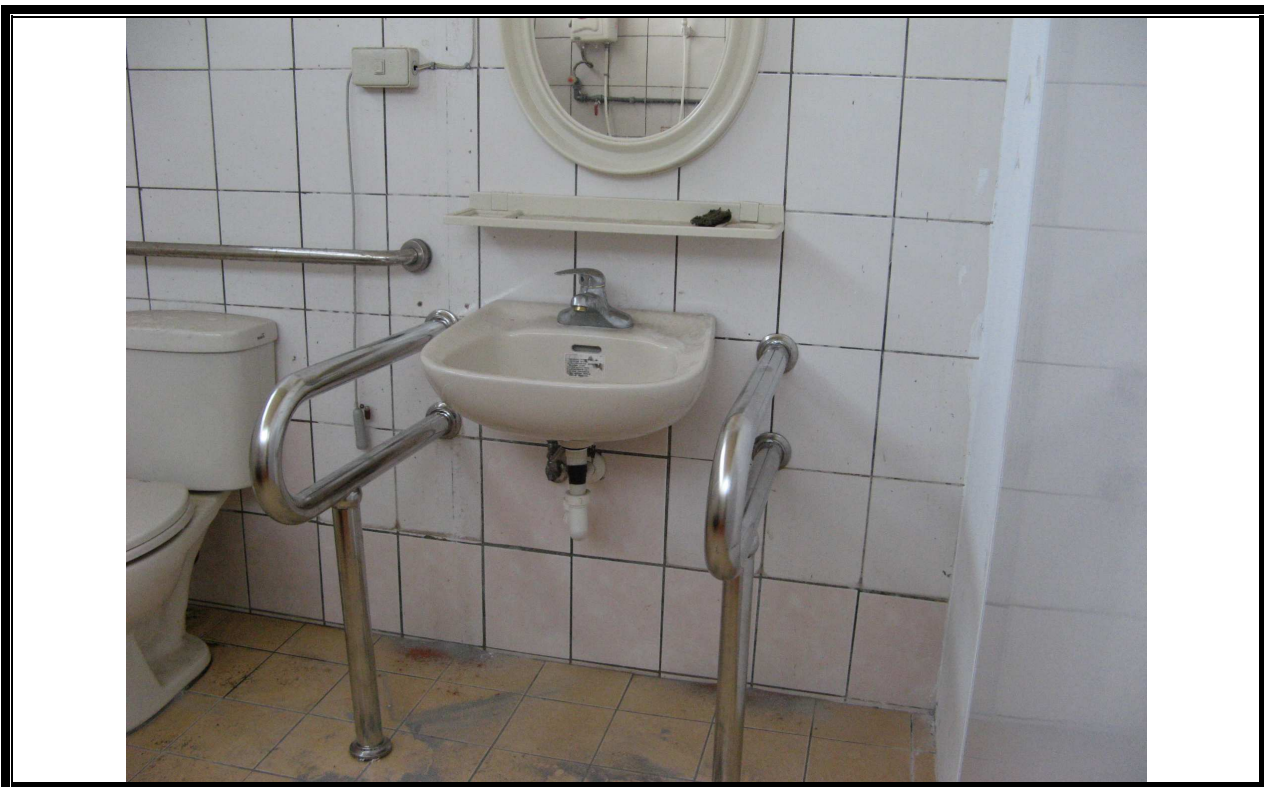
說明：廁所扶手施工完工照片
