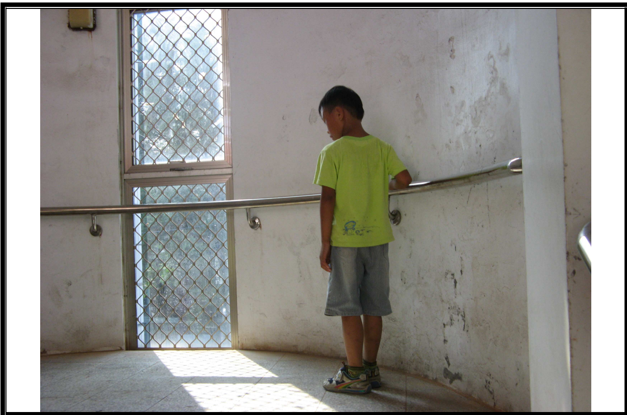
說明：樓梯扶手施工完成照片
