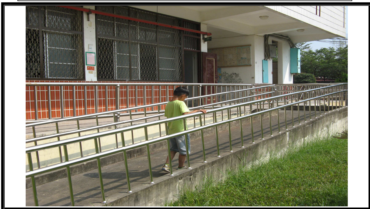
說明：坡道不銹鋼扶手完工
