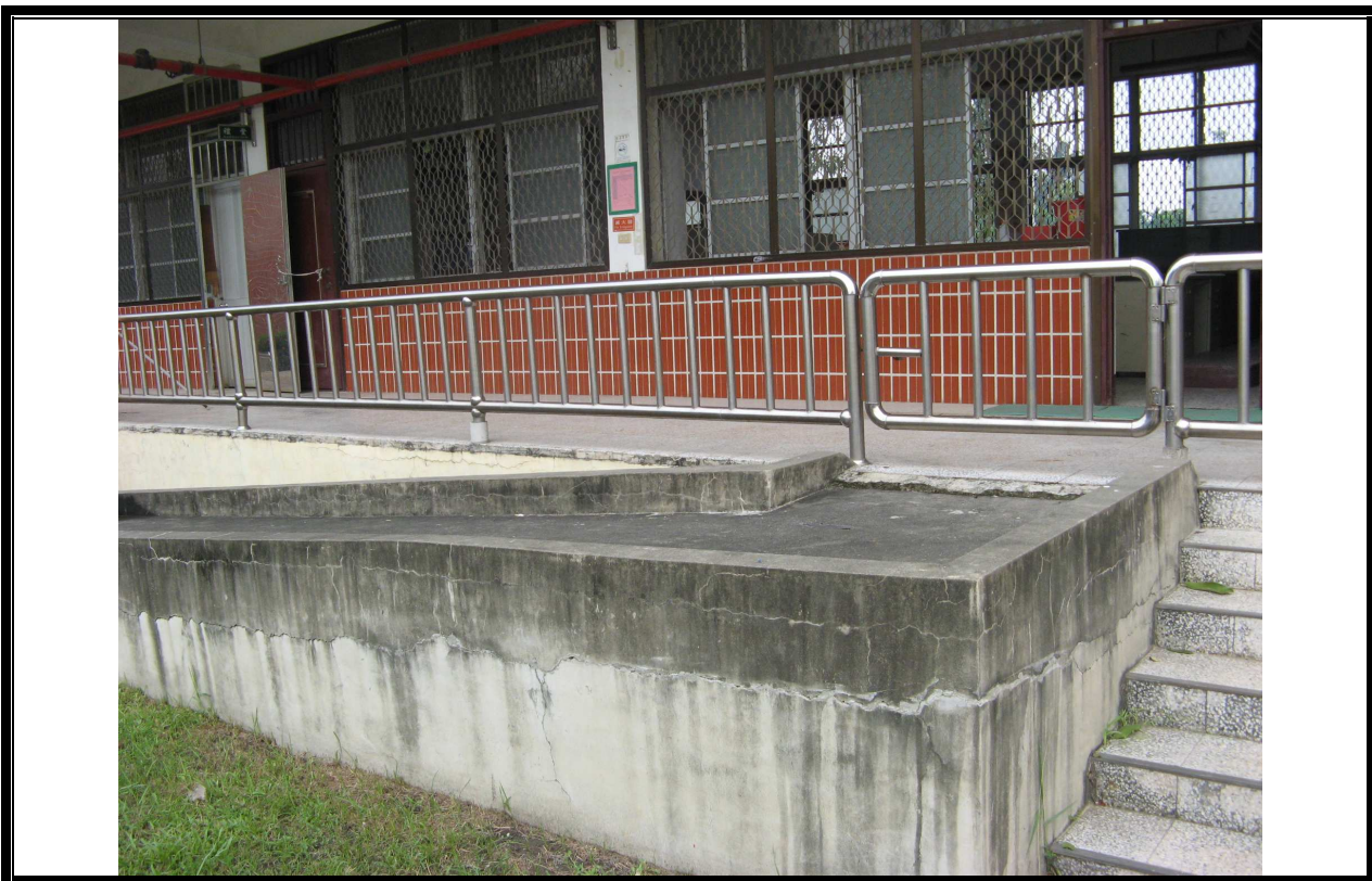
說明：坡道施工前照片
