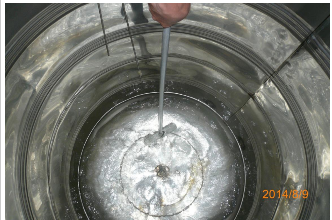
水塔清潔照片
