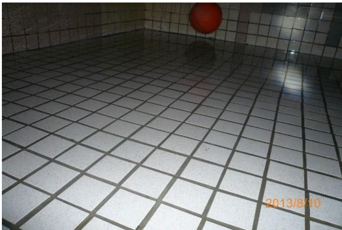
蓄水池清潔照片-清洗後
