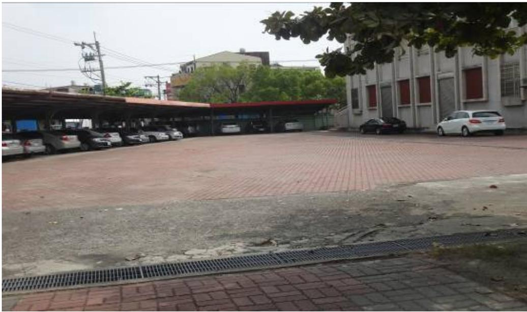
照片說明：教職員工停車位採用透水性高之連鎖磚鋪設，避免校園過度水泥化
