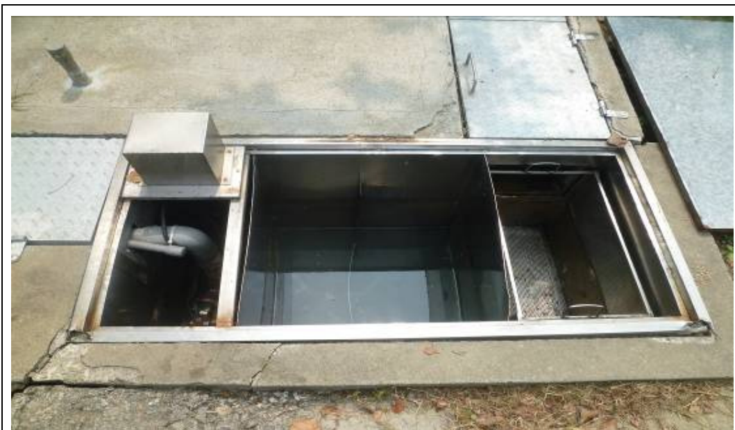
照片說明：午餐廚房設置汙水處理槽
