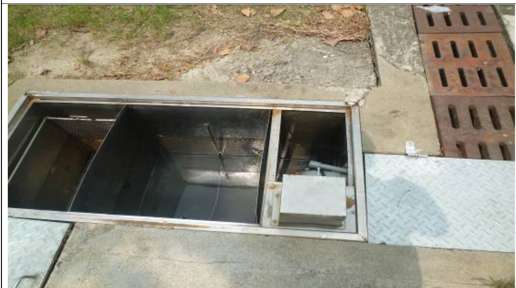
照片說明：午餐廚房設置汙水處理槽
