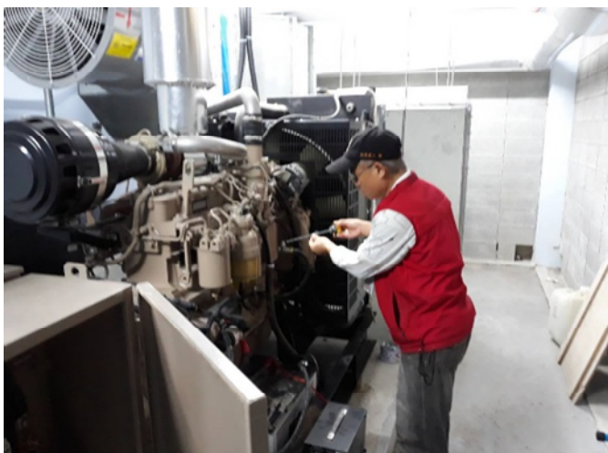
協助配合立丞電機定期檢查地下室配電室及試發運轉發電機
