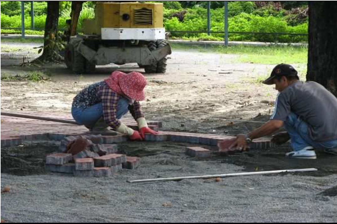
說明：鋪設連鎖磚工程施工情形
