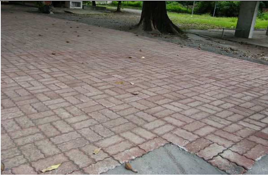
說明：鋪設連鎖磚工程完工情形
