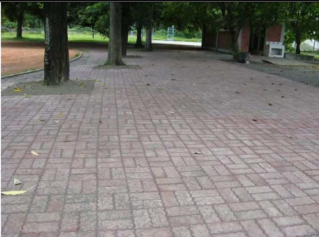
說明：鋪設連鎖磚工程完工情形
