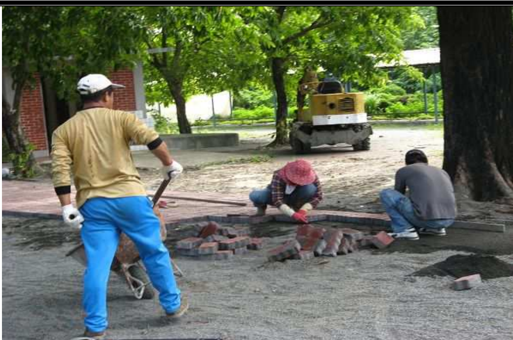
說明：鋪設連鎖磚工程施工情形
