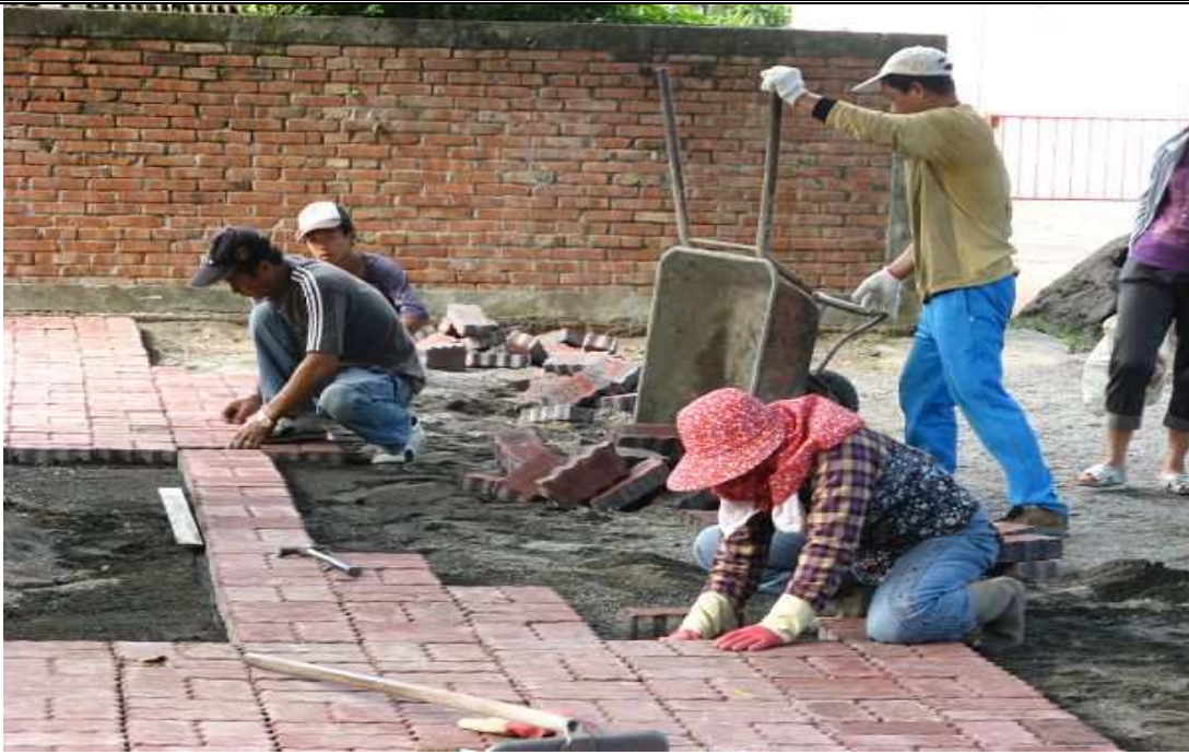
說明：鋪設連鎖磚工程施工情形
