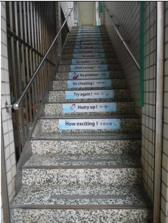
說明：樓梯間設置無障礙扶手
