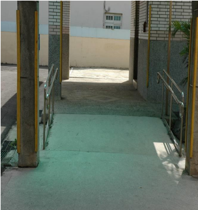
說明：廁所旁設置無障礙坡道
