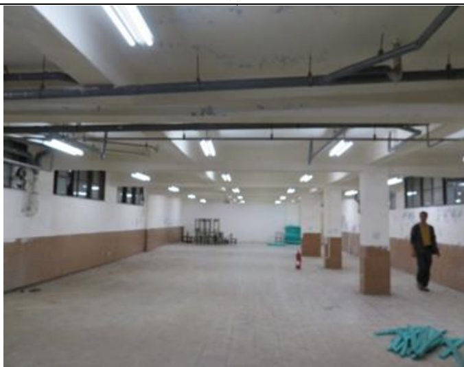
迎曦樓地下室全面汰換成 LED 燈管
