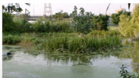
經由礫間污水處理過的水引進這個池子，再經過植物的淨化作用之後，變成農場用水。
