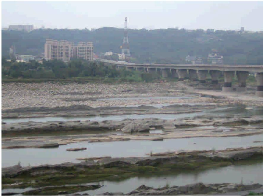
圖 4 是拍攝於桃園大溪武嶺橋畔，大漢溪部分河床面貌，可從中觀察到由於河床缺乏上游的石頭、砂礫、泥土的補充，所以流水直接侵蝕、沖刷河床，導致河床底部岩層裸露嚴重。
